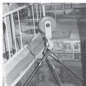
・定格荷重をゆっくりと吊った後にワイヤグリップの増し締めを行い、その他に異常がないことを確認する。締付トルクを第20表に示します。
